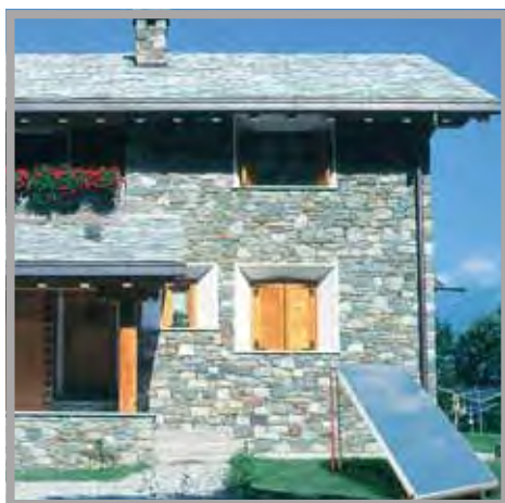
Пример наземного монтажа
